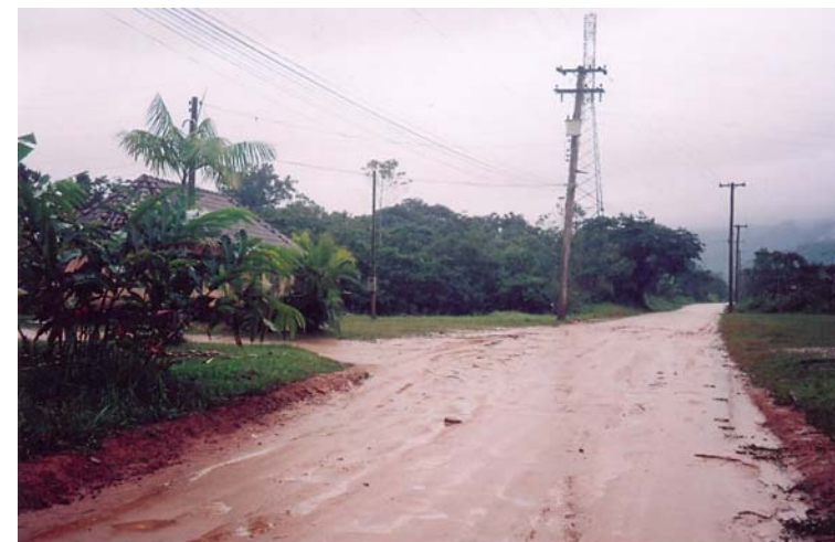
FOTO BER-06 MUNICÍPIO DE BERTIOGA (Agosto de 2008) Estrada do Guarani em frente ao prédio FUNAI e do Posto Médico Municipal Instalado a cerca de 100 m da porteira de acesso à Aldeia Indígena Rio Silveiras
