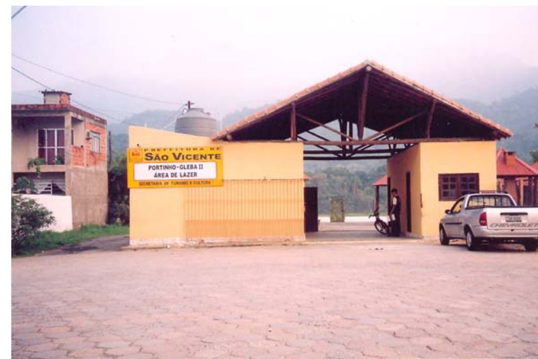
FOTO SVI-26 MUNICÍPIO DE SÃO VICENTE (Setembro de 2008) Vista fachada principal do Atrativo Turístico “Portinho”, com o Rio Branco ao fundo, no centro da fotografia
