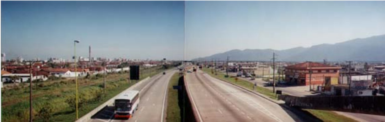
FOTO PRAIA GRANDE 01 RODOVIA PADRE MANOEL DA NÓBREGA SP 55 (Orientação da foto: Santos - Peruíbe)
