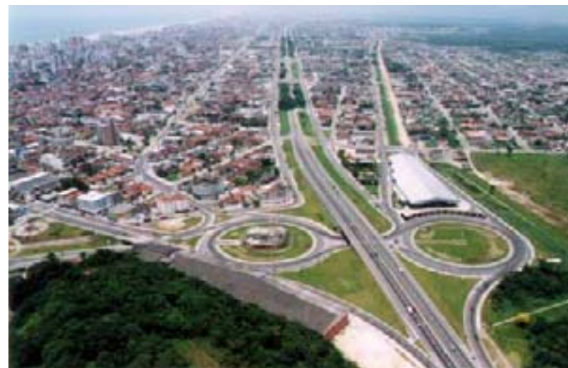
VISTA DA ROTATÓRIA E DA RODOVIÁRIA NA SP 291 NA PRAIA GRANDE
