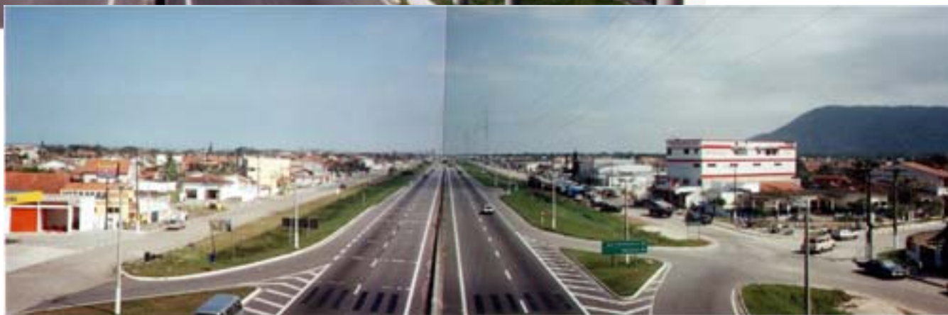
FOTO MONGAGUÁ 06 RODOVIA PADRE MANOEL DA NÓBREGA SP 55 ENTRE AS AVS. MONTREAL E PALMEIRAS (Orientação da foto: Santos Peruíbe)
