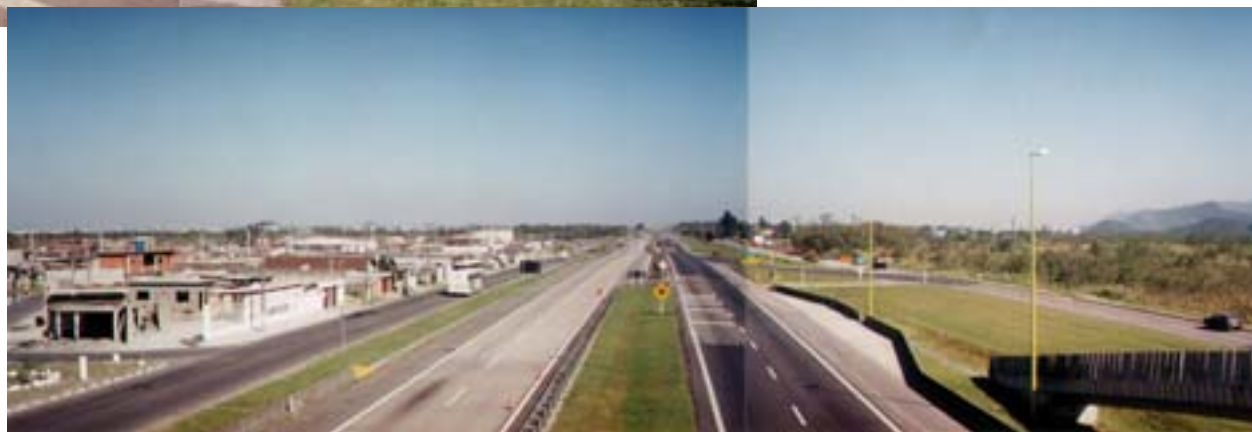
FOTO SÃO VICENTE 02 RODOVIA PADRE MANOEL DA NÓBREGA SP 55 (Orientação da foto: Rod. dos Imigrantes - Mongaguá)
