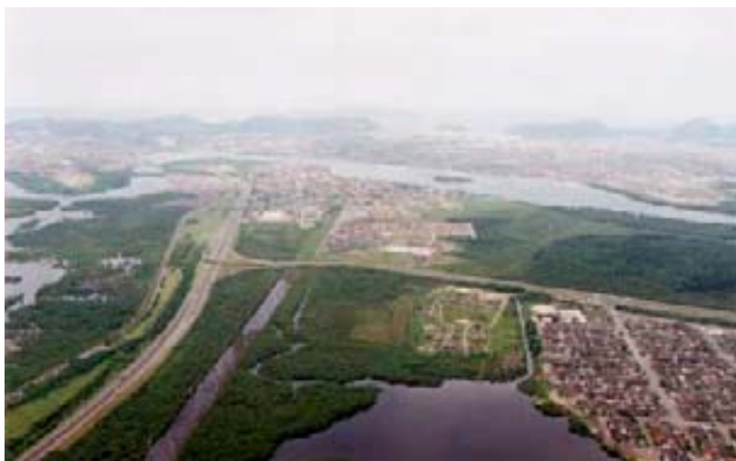
VISTA DA INTERSEÇÃO DA ROD. ANCHIETA – SP 150 COM A INTERLIGAÇÃO DA BAIXADA SP 59
