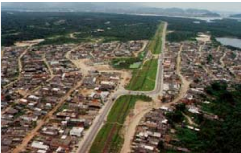
VISTA DA FERROVIA (LINHA AMARELA) EM SAMARITÁ, SÃO VICENTE
