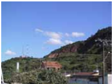
MON12PON23FOT01 - Encosta do morro com deslizamentos próximo a torre de TV
