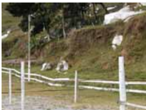
GUA58PON165FOT05 - Encosta do morro cortada na parte inferior
