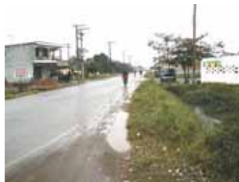
ITA07PON21FOT01 - Vala existente na lateral do viário
