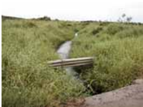
ITA01PON02FOT01 - Rio do Poço a jusante de uma travessia
