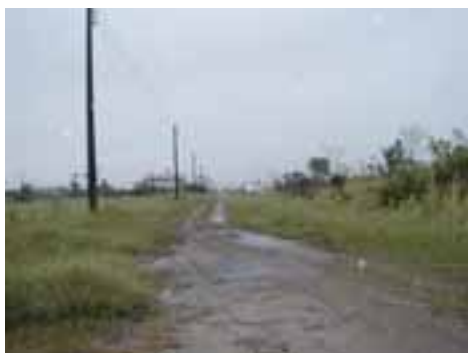
PER15PON37FOT03 - Microdrenagem inexistente
