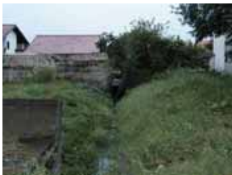
PER12PON31FOT01 - Canalização existente
