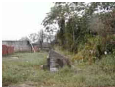
MON07PON14FOT01 - Canal existente junto ao lançamento
