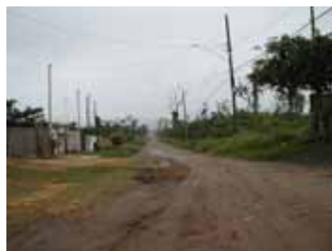
PER01PON07FOT01 - Microdrenagem inexistente
