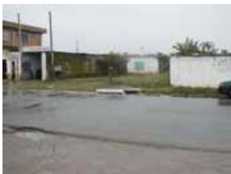
PER03PON13FOT02 - Microdrenagem insuficiente
