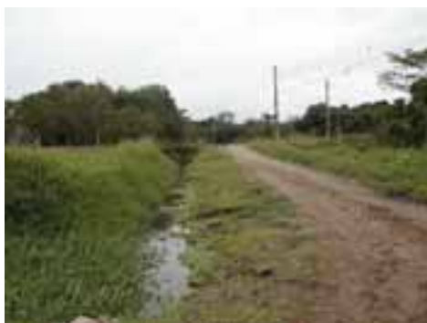
PER14PON35FOT01 - Vala lateral à rua
