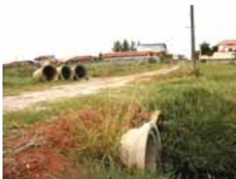
ITA01PON01FOT03 - Travessia do Rio do Poço
