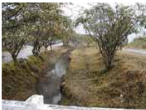
PER08PON22FOT02 - Canalização existente
