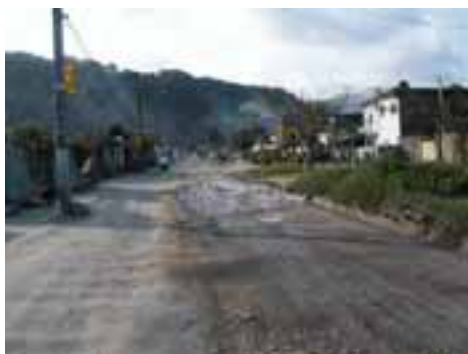
GUA57PON161FOT02 - Viário com microdrenagem inexistente
