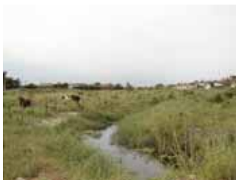
ITA01PON01FOT01 - Rio do Poço assoreado
