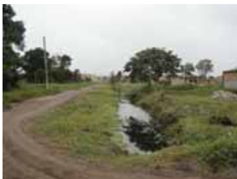
PER14PON35FOT02 - Vala lateral à rua
