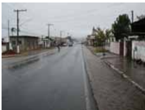
PER04PON14FOT01 - Microdrenagem com problemas de obstrução ou limpeza
