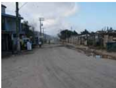
GUA57PON162FOT02 - Viário com microdrenagem inexistente
