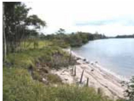
ITA09PON25FOT04 - Detalhe da erosão na margem direita do Rio Itanhaém
