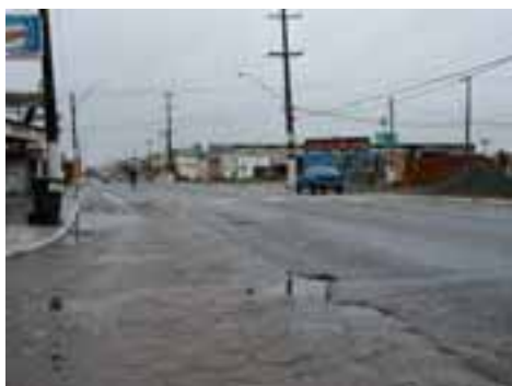
PER19PON43FOT03 - Microdrenagem obstruída e insuficiente
