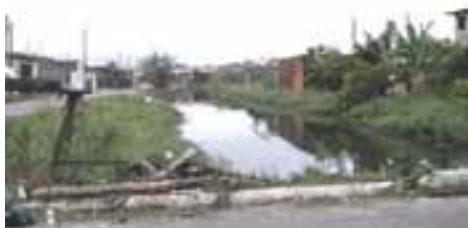
ITA05PON16FOT01 - Calha do rio Campininha com ocupações nas margens
