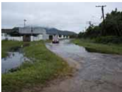
MON03PON07FOT02 - Sistema viário sem pavimentação e sem drenagem adequada
