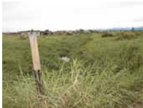
ITA01PON02FOT02 - Rio do Poço com as margens obstruídas
