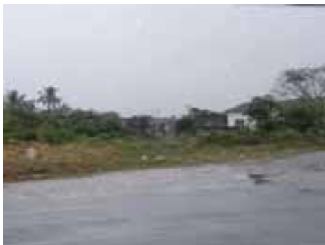
PER03PON13FOT01 - Microdrenagem insuficiente
