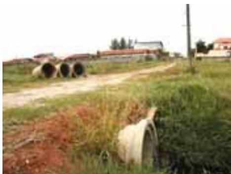
ITA01PON01FOT03 - Travessia do Rio do Poço
