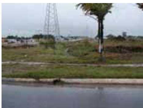
PER18PON42FOT03 - Microdrenagem obstruída e insuficiente
