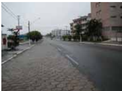
PER16PON40FOT01 - Microdrenagem com problemas de obstrução ou limpeza
