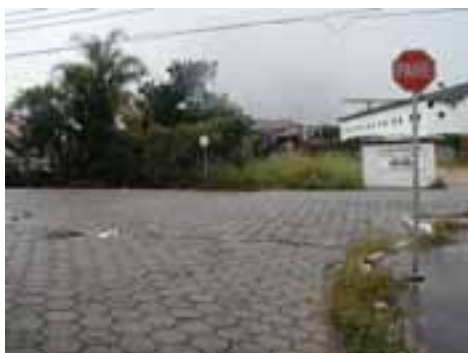
PER09PON25FOT01 - Lançamento da microdrenagem
