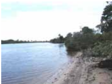
ITA09PON25FOT01 - Trecho de erosão margem direita do Rio Itanhaém vista montante para jusante
