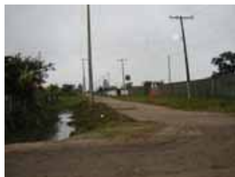
PER01PON04FOT01 - Microdrenagem inexistente
