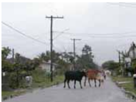
MON02PON06FOT02 - Microdrenagem obstruída e insuficiente
