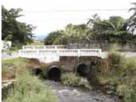
ITA02PON05FOT01 - Travessia do Rio do Poço na Rua Pedro Américo
