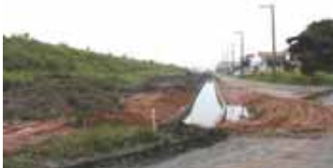
ITA04PON13FOT01 - Canalização em obras
