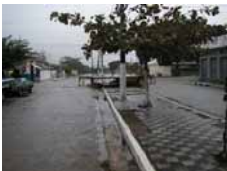
PER06PON19FOT01 - Microdrenagem obstruída e insuficiente
