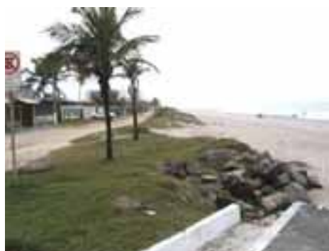
ITA10PON28FOT01 - Erosão ao longo da praia junto a Av. Pres. Vargas
