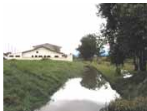
ITA03PON11FOT01- Curso d'água do córrego Bicudo próximo à Rua 31 de Março
