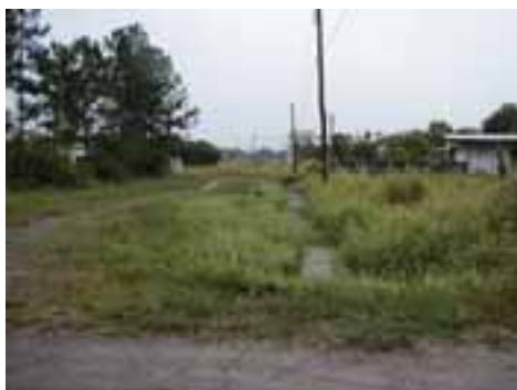
PER17PON41FOT02 - Microdrenagem inexistente
