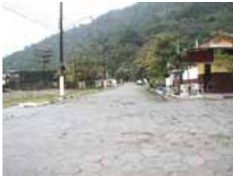
SVI61PON105FOT01 - Viário com microdrenagem recém implantada
