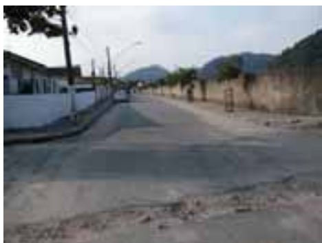
SVI76PON129FOT05 - Viário com microdrenagem insuficiente
