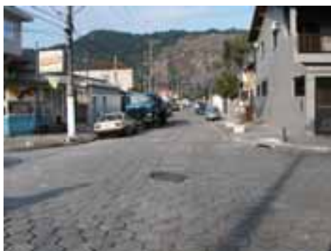
SVI75PON126FOT01 - Viário com microdrenagem insuficiente
