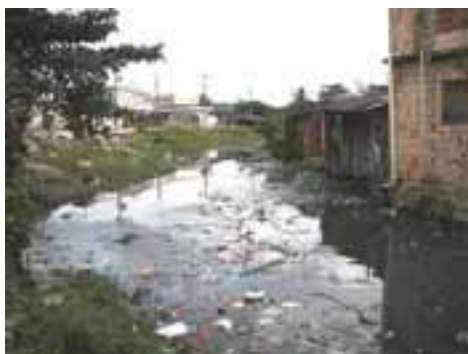
SVI44PON76FOT01 - Canal próximo ao dique sem comporta
