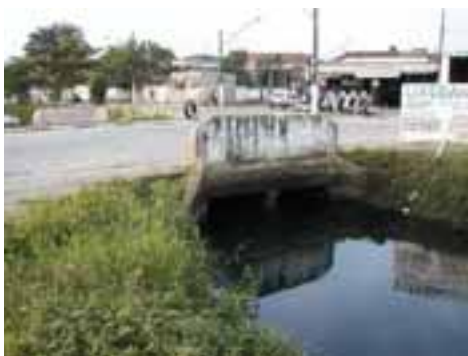
SVI70PON119FOT01 - Canal e travessia existente
