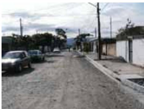
SVI28PON51FOT01 - Viário com microdrenagem recém implantada
