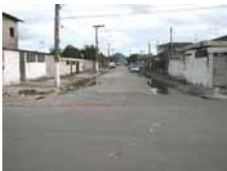
SVI48PON81FOT01 - Viário com microdrenagem insuficiente e afetado pela maré
