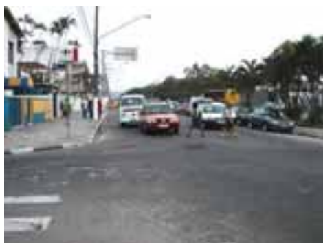
SVI66PON112FOT01 - Viário com microdrenagem insuficiente
