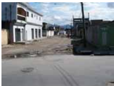
SVI54PON92FOT02 - Viário com microdrenagem insuficiente
