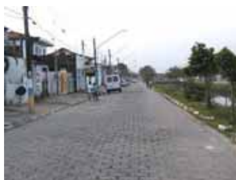
SVI70PON118FOT01 - Viário com microdrenagem insuficiente
