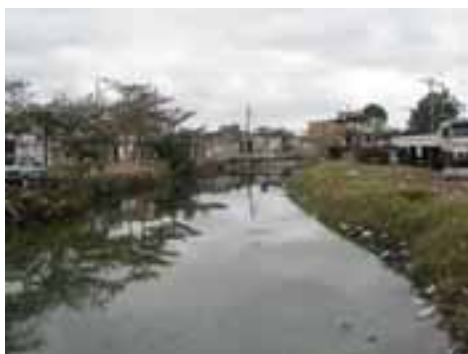
SVI32PON68FOT01 - Canal existente junto ao viário
