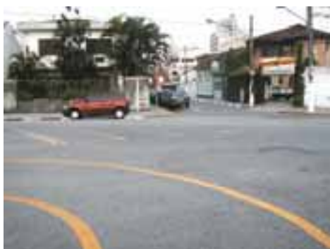
SVI67PON113FOT03 - Viário com microdrenagem insuficiente
