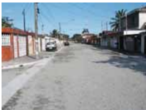
SVI28PON51FOT02 - Viário com microdrenagem recém implantada
