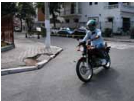
SVI79PON136FOT01 - Viário com microdrenagem obstruída e danificada
