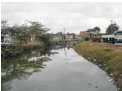
SVI32PON68FOT01 - Canal existente junto ao viário
