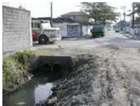
SVI76PON129FOT01 - Vala a céu aberto na lateral do viário
