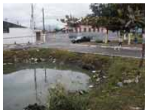
SVI32PON68FOT03 - Canal existente assoreado
