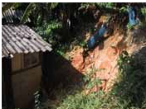
SVI81PON144FOT01 - Talude deslizado sobre barraco.
