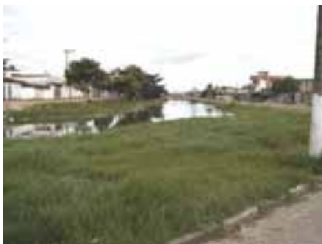
SVI45PON77FOT01 - Canal próximo ao dique sem comporta
