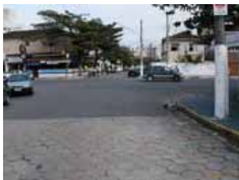
SVI77PON132FOT01 - Viário com microdrenagem e pavimento recém reformado
