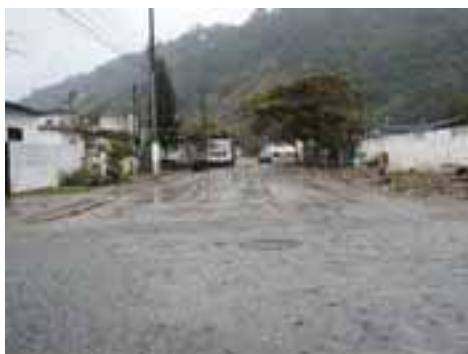
SVI63PON107FOT01 - Viário com microdrenagem recém implantada
