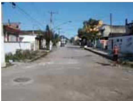
SVI29PON53FOT01 - Viário com microdrenagem recém implantada
