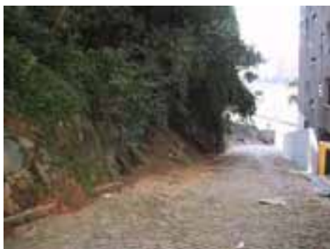
SVI80PON138FOT02 - Vista de edifício e rua de acesso as garagens do mesmo localizado no pé da encosta, sob risco de novos deslizamentos.
