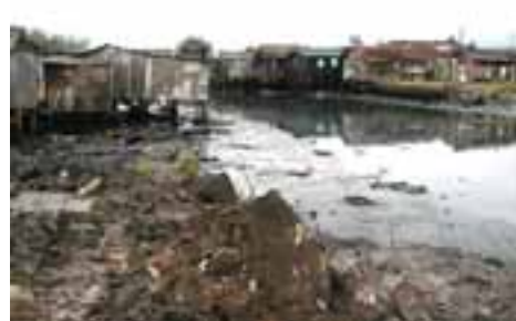
SVI33PON60FOT02 - Detritos e assoreamento no canal existente
