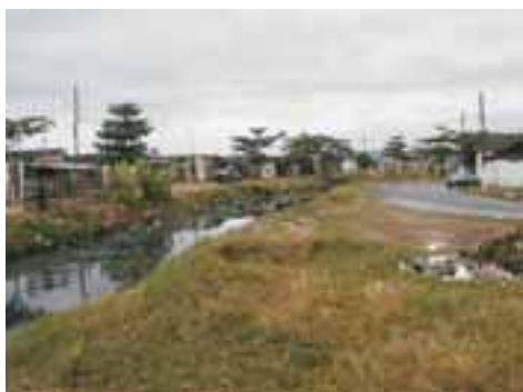
SVI32PON56FOT01 - Canal existente junto ao viário
