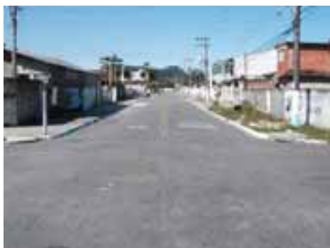
SVI30PON54FOT02 - Viário com microdrenagem assoreada e obstruída
