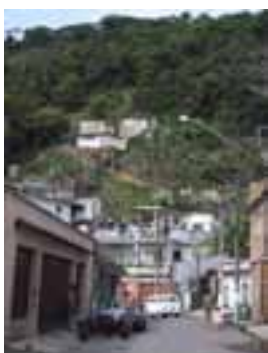
SVI81PON141FOT01 - Casa em área de risco na meia encosta do morro
