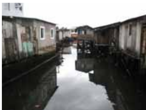
SVI36PON66FOT03 - Canal existente com invasões irregulares
