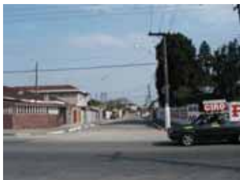
SVI41PON183FOT01 - Viário com microdrenagem insuficiente
