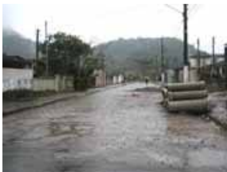
SVI64PON108FOT01 - Viário com microdrenagem recém implantada
