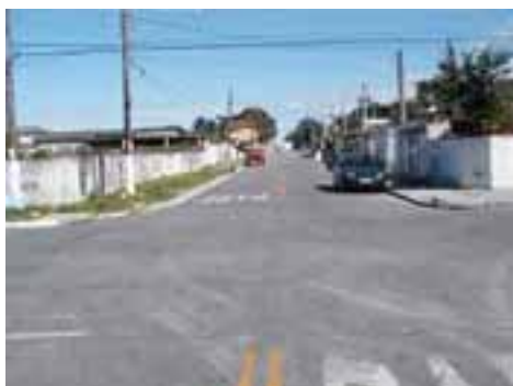
SVI30PON54FOT03 - Viário com microdrenagem assoreada e obstruída
