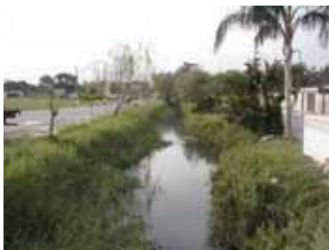
SVI70PON120FOT01 - Canal existente sem revestimento
