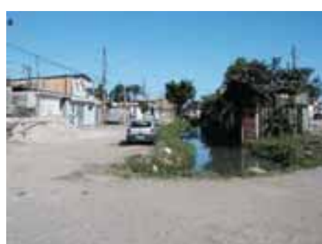
SVI51PON86FOT03 -Canal existente lateral ao viário
