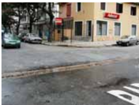
SVI74PON125FOT01 -Viário com microdrenagem insuficiente
