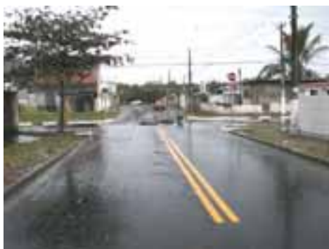
SVI60PON104FOT01 - Viário com microdrenagem recém implantada
