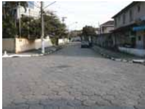
SVI73PON124FOT01 - Viário com microdrenagem assoreada e obstruída
