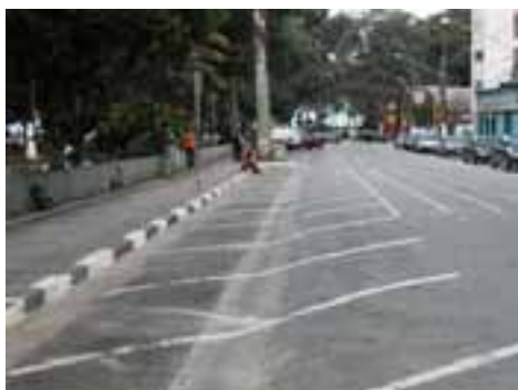
SVI68PON115FOT01 - Viário com microdrenagem insuficiente
