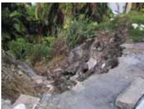
SVI84PON156FOT01 - Detalhe de deslizamento de encosta junto ao final da Al. Paulo Gonçalves
