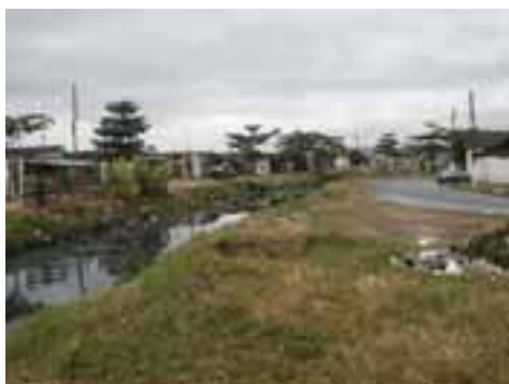
SVI32PON56FOT01 - Canal existente junto ao viário
