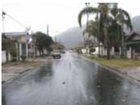
SVI60PON104FOT02 - Viário com microdrenagem recém implantada
