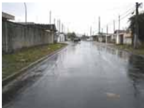
SVI59PON102FOT01 - Viário com microdrenagem recém implantada
