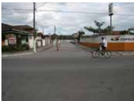
SVI42PON74FOT02 - Viário com microdrenagem insuficiente
