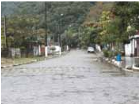
SVI61PON105FOT02 - Viário com microdrenagem recém implantada
