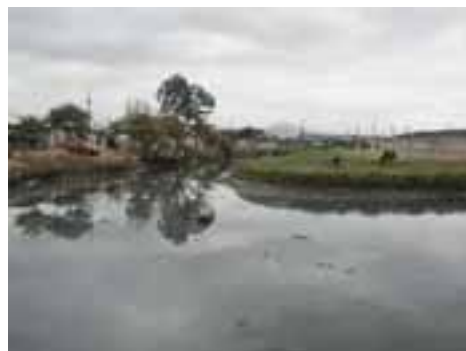
SVI36PON66FOT02 - Canal próximo ao dique com necessidade de comporta
