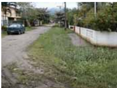
BER05PON09FOT03 - Inexistência de microdrenagem
