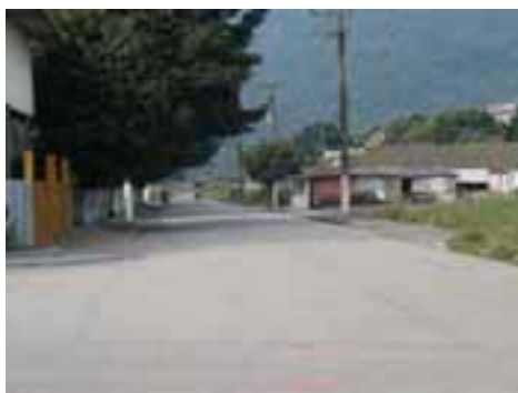
CUB09PON18FOT02 - Bairro com microdrenagem insuficiente em área de preservação ambiental
