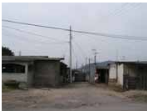
CUB05PON11FOT01 - Bairro com microdrenagem insuficiente
