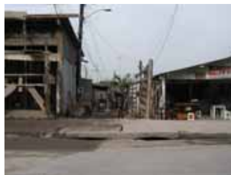
CUB03PON07FOT01 - Viário com microdrenagem insuficiente
