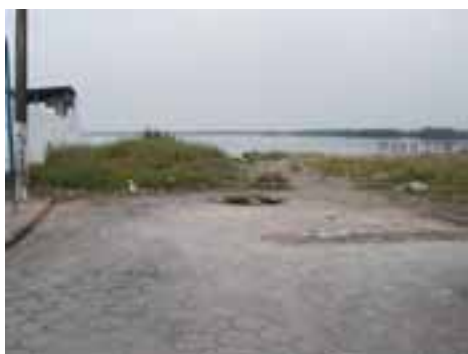
CUB06PON12FOT03 - Viário próximo ao Mar Pequeno
