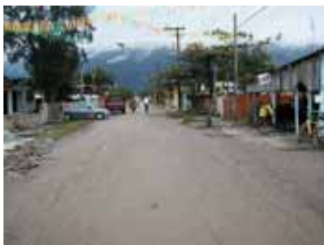
BER03PON06FOT01 - Inexistência de microdrenagem
