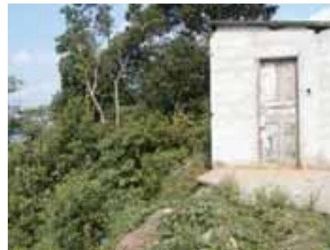
CUB12PON26FOT01 - Barraco com risco de deslizamento junto com encosta.
