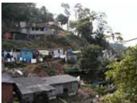
CUB14PON30FOT02 - Barracos em área de risco de deslizamento.
