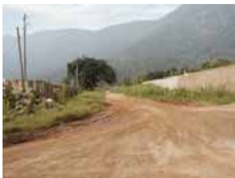
CUB09PON18FOT04 - Bairro com microdrenagem insuficiente em área de preservação ambiental
