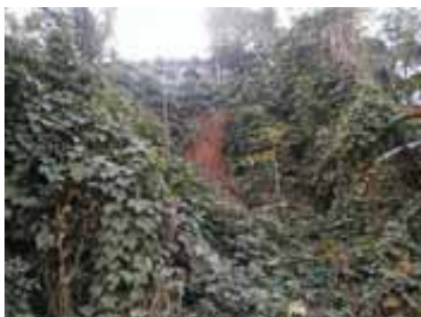
CUB17PON43FOT04 - Encosta com habitações no topo em risco de deslizamento.
