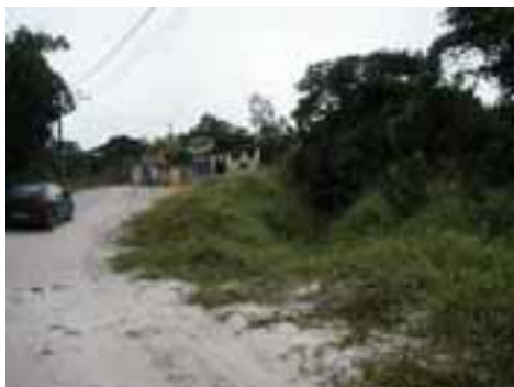
BER15PON28FOT02 - Canal existente assoreado
