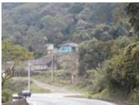
CUB11PON48FOT02 - Vista geral da ocupação irregular em área perenente ao Parque Estadual da Mata Atlântica, com poucas habitações próxima a cota 500.
