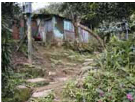
CUB10PON20FOT02 - Detalhe de barraco em área de risco.
