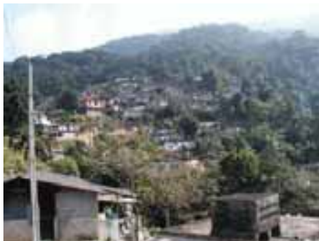
CUB12PON25FOT01 - Vista geral das ocupações da encosta.
