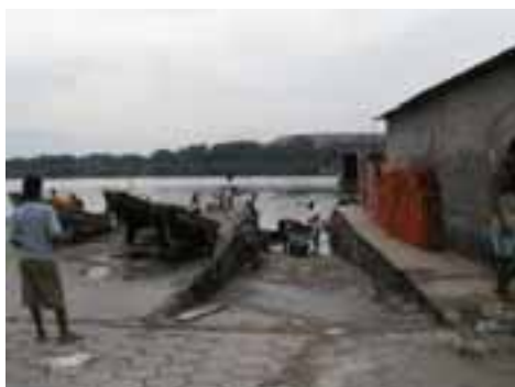
CUB07PON14FOT04 - Bairro com microdrenagem insuficiente e lançamento afetado pela maré
