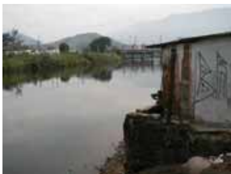
CUB08PON15FOT02 - Bairro com microdrenagem insuficiente e lançamento afetado pela maré
