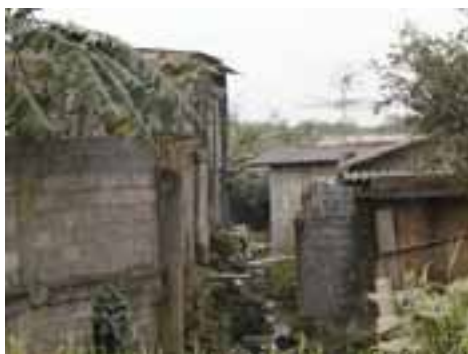
CUB03PON05FOT02 - Ocupações junto a área de proteção ambiental / mangue
