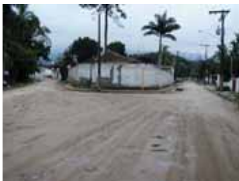
BER01PON03FOT01 - Inexistência de microdrenagem
