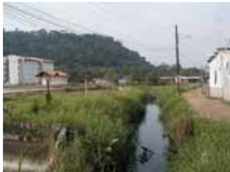
CUB04PON08FOT03 - Curso d'água existente sem canalização adequada
