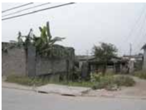
CUB03PON05FOT01 - Ocupações junto a área de proteção ambiental / mangue
