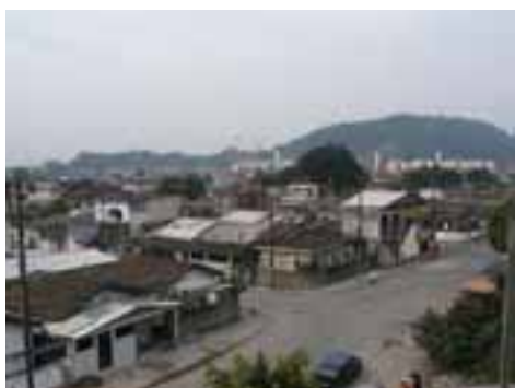
CUB05PON11FOT02 - Bairro com microdrenagem insuficiente
