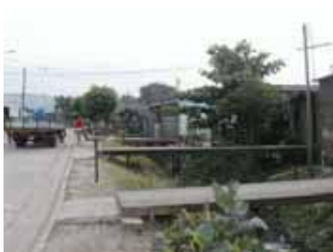
CUB04PON10FOT03 - Curso d'água existente sem canalização adequada
