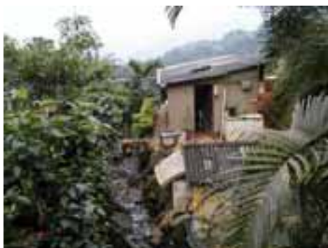
CUB10PON19FOT03 - Barraco, junto a área de drenagem natural de encosta
