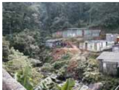
CUB14PON30FOT01 - Barracos em área de risco de deslizamento, junto a linha de drenagem natural da encosta.
