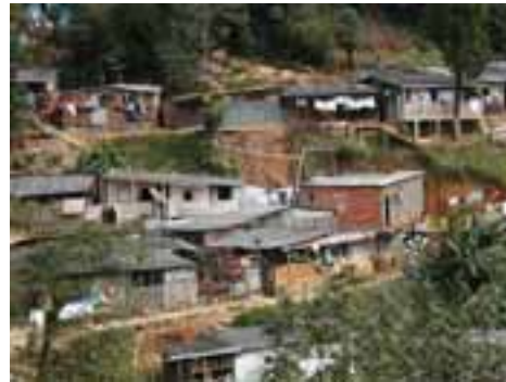
CUB15PON32FOT04 - Vista geral das ocupações em área de encosta.
