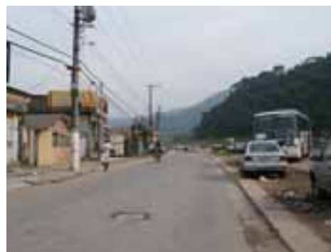
CUB03PON06FOT01 - Viário com microdrenagem insuficiente
