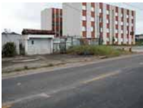
BER10PON16FOT02 - Viário com microdrenagem insuficiente
