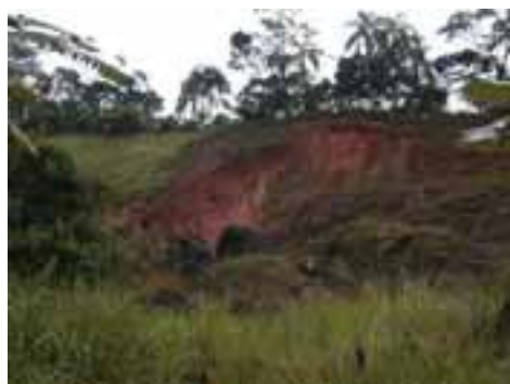
BER17PON32FOT01 - Área de erosão / deslizamento próximo à pista da Rod. Manoel Hyppólito do Rego
