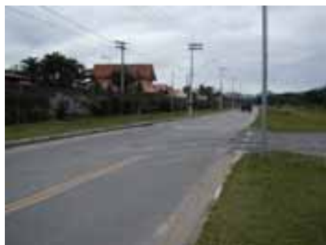
BER07PON12FOT01 - Viário com microdrenagem insuficiente
