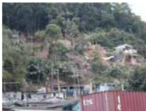
CUB16PON39FOT02 - Vista geral das ocupações na encosta com risco de deslizamento sobre a pista de acesso à Rodovia dos Imigrantes.
